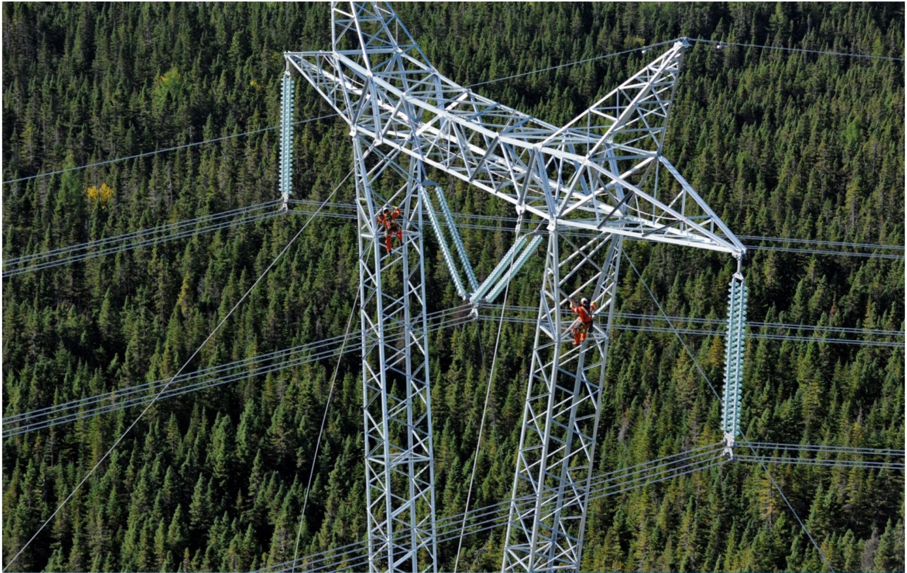
Inspection d'un pylône en V haubané de la nouvelle ligne de la Romaine-2-Arnaud
